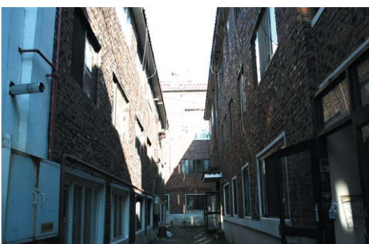
▲ "낮에도 이렇게 어두운데 밤에는 앞뒤분간도 안가" 사진 속 삼일 빌라에 사는 주민이 말했다.
